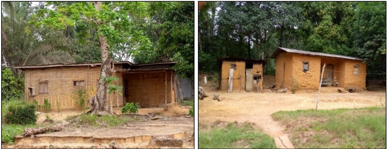
Photo 8 : Vues des logements traditionnels des villages Batombe et Metounga
