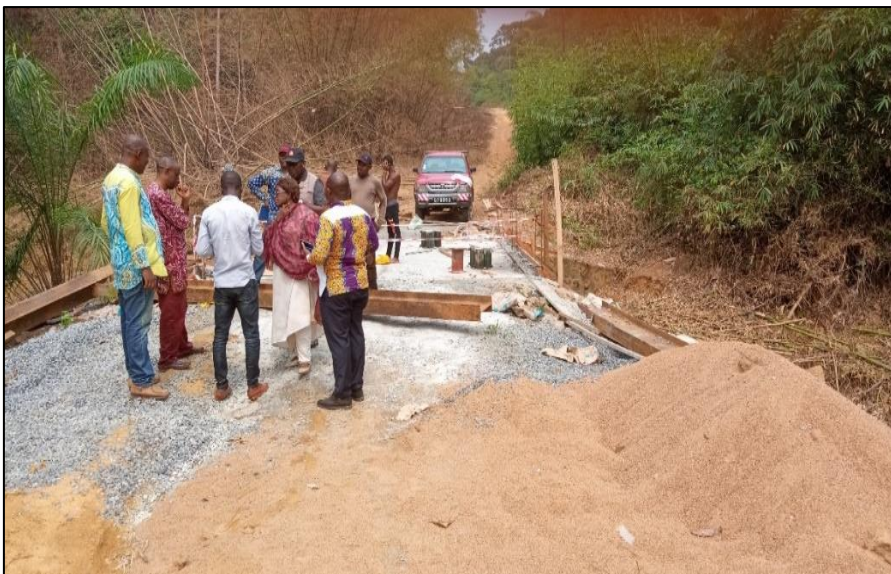
Photo 17 : Vue d'un ouvrage en construction sur la rivière Ossombah
