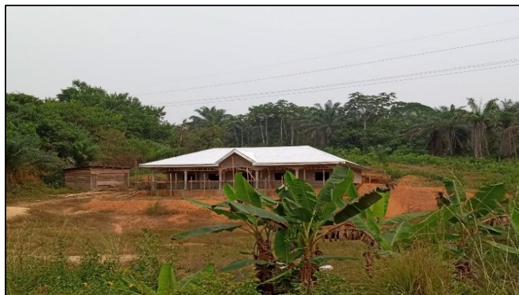
Photo 6 : Construction sous la ligne haute tension à Metounga Source : Investigations de Keys of services, 2020
